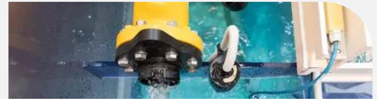
Management von Wasser- & Abwasseranlagen
